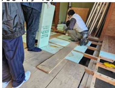
床下に断熱材を入れる様子
